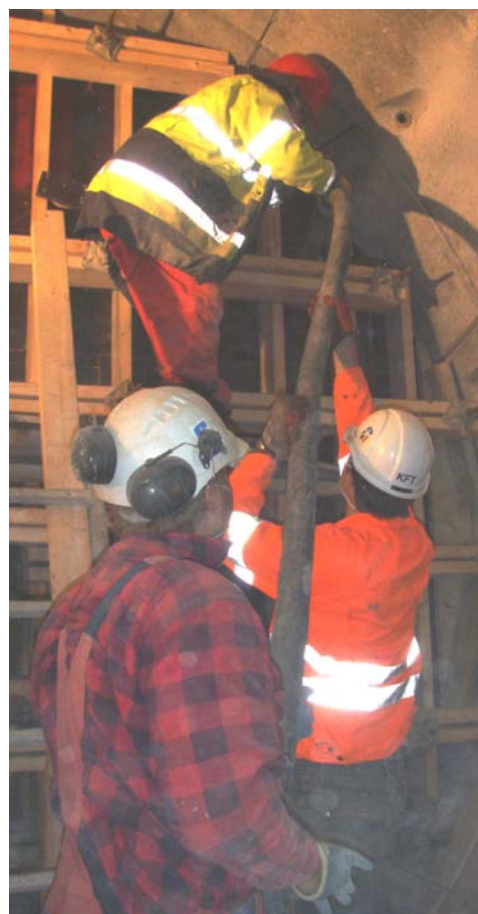
Støbningen er i gang. Materialet pumpes ind igennem 6 åbninger i forskallingen.
