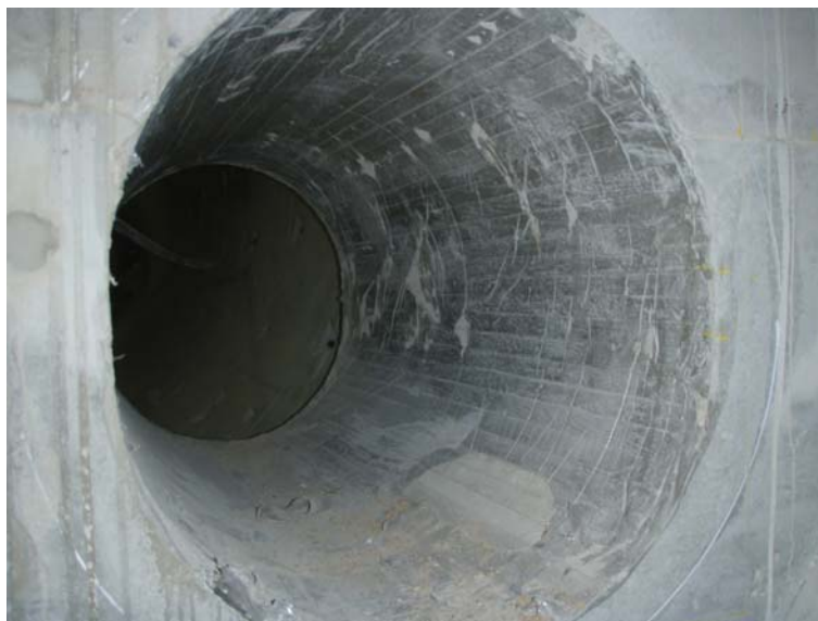
Detalje fra støbningen efter afforskalling.
