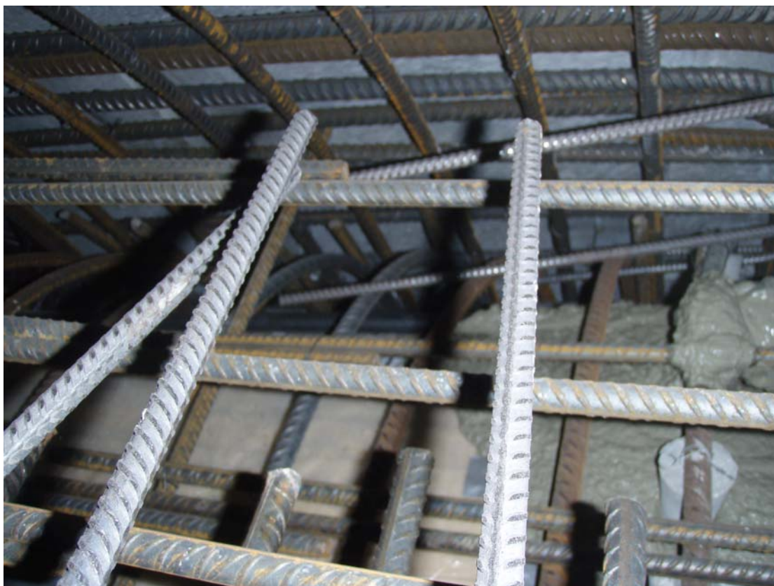
Inde i forskallingen ses betonen flyde hen over en udsparring.
