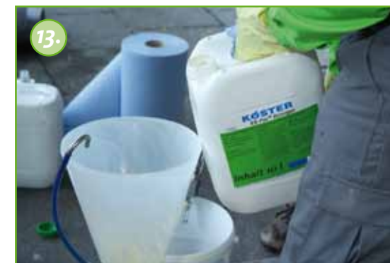
13. Pumpen renses med KÖSTER KB-PUR® Rensemiddel som anbefalet i pumpens brugsanvisning.
