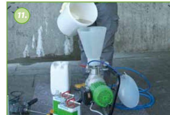
11. Pumpen forberedes til injektion som anbefalet i brugsanvisningen og den blandede kunstharpiks fyldes i materialetragten. Det færdigblandede materiale skal bruges indenfor forarbejdningstiden.
