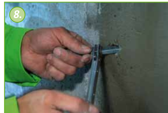
8. Pakningen strammes med en skruenøgle.
