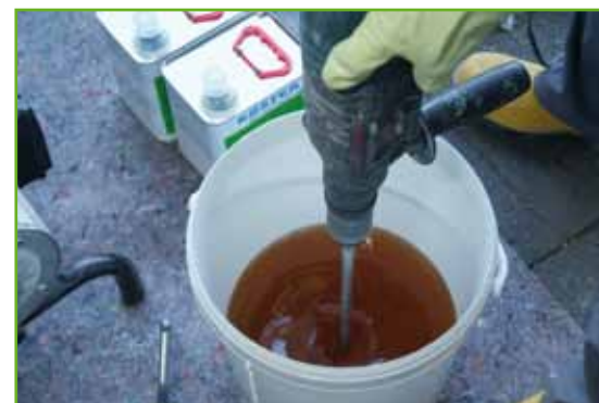
En egnet omrører såsom KÖSTER Kunstharpiksblender anvendes sammen med et langsomt roterende mekanisk blandeaggregat til at blande begge komponenter til et homogent materiale.
