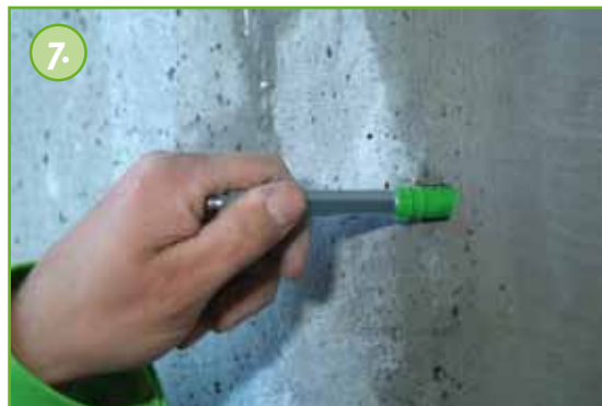
7. KÖSTER Superpakninger placeres i borehullerne, bortset fra omtrent hvert tredje borehul der lades stå tomt.
