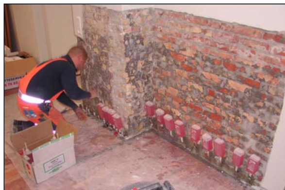
Injektion med vinkler
