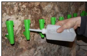
Vanding af kapillarstave over vinklerne
